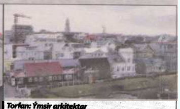
Torfan: Ýmsir arkitektar „Sumt er ekki hægt að hanna – það bara gerist með tímanum. Torfan er gott dæmi um þetta. Mannlegur mælikvarði og fjölbreytni. Það eru ekki nema rúmlega þrjátíu ár síðan það átti að rífa þetta!“ „Mjög verðmætt í sögu Íslendinga. Verðum að halda í þetta. Þægilegt andrúmsloft, manni líður vel barna.“
